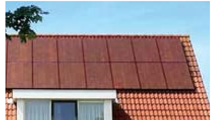
Rode PV-panelen Foto: todoensolar.com
